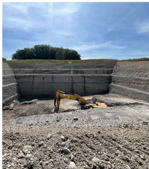
Bei den Inspektionen des Verbandes wird genau hingeschaut.
