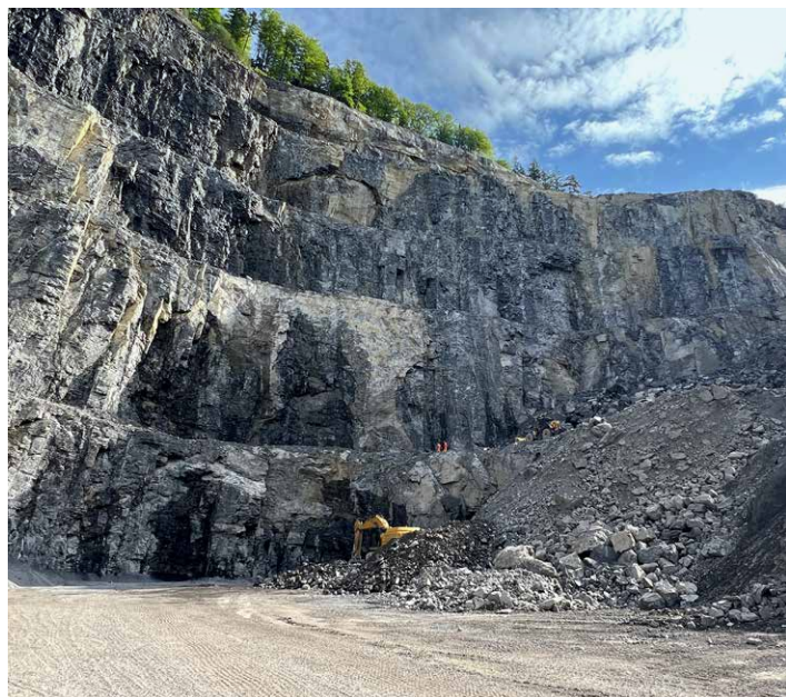
Nel corso delle ispezioni non sono state riscontrate gravi infrazioni.
